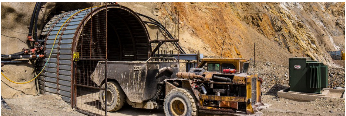
I-80 Gold Corp. mine portal, Nevada, USA.
