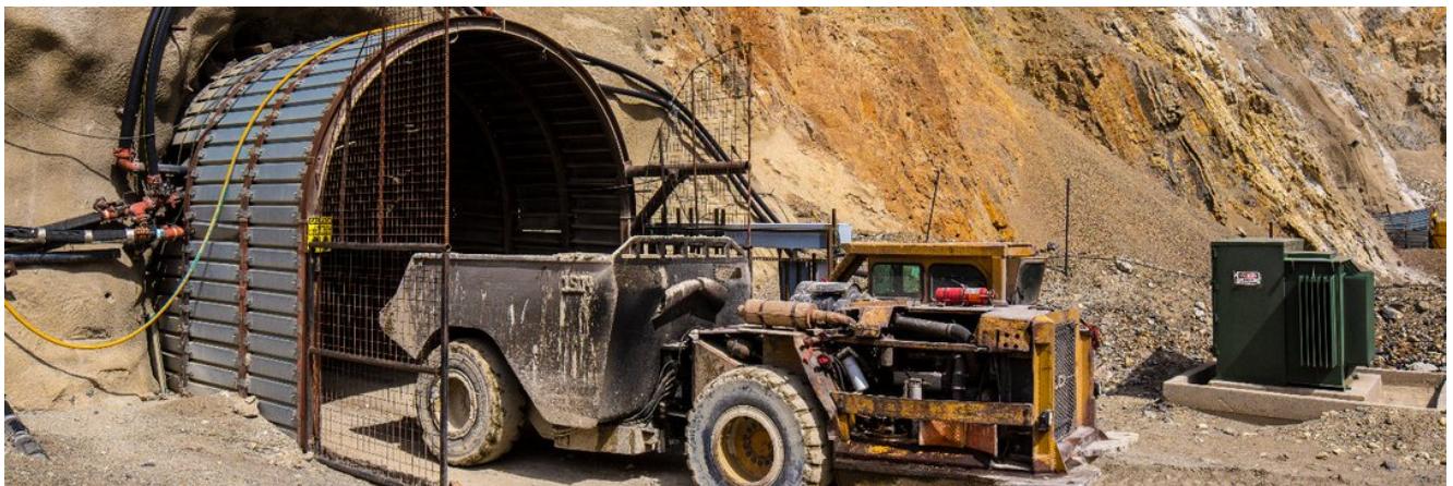
I-80 Gold Corp. mine portal, Nevada, USA.
