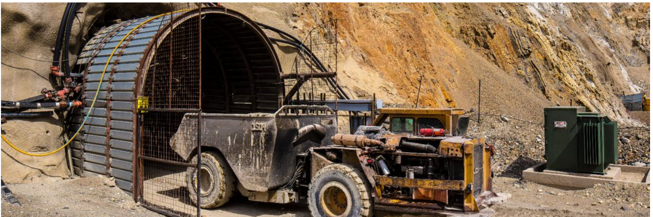
I-80 Gold Corp. mine portal, Nevada, USA.
